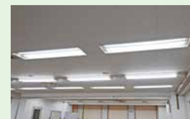
LED照明の導入
