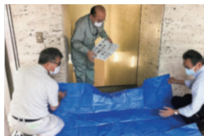
水害対策(水のう設置テスト)
