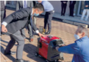
発電機テスト
