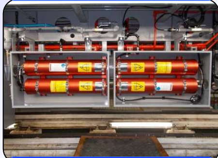
鉄道車両エンジンルーム
