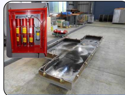
風力発電設備(タワー内)
