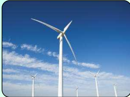
風力発電設備
